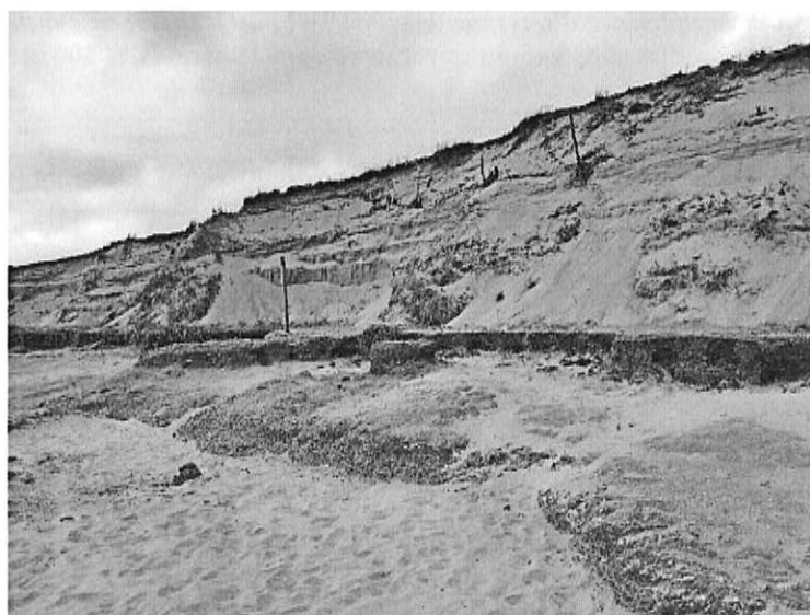
Photo n° 7 : Zone d'érosion sur la plage de la Normandelière
