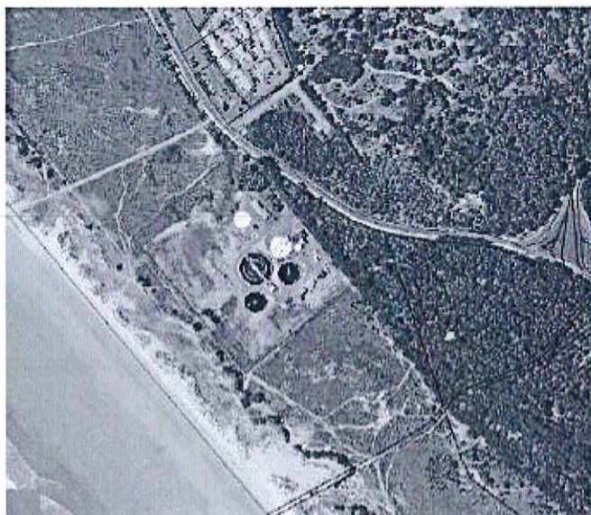
Photo n° 8 : Station d'épuration des 60 Bornes
