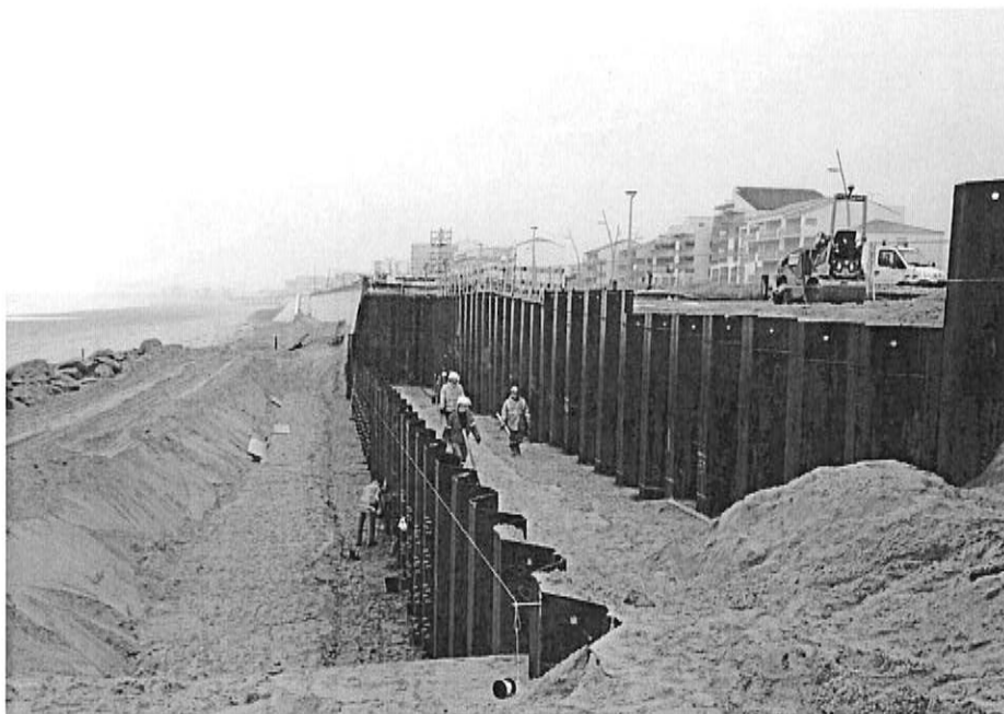
Photo n° 9 : Travaux réalisés sur le perré des Demoiselles (Saint-Hilaire-de-Riez) en 2016
